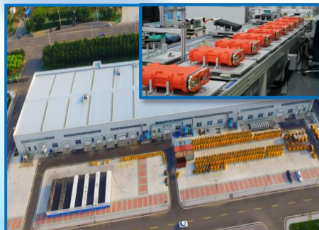
海底地震海底节点和拖缆系统
